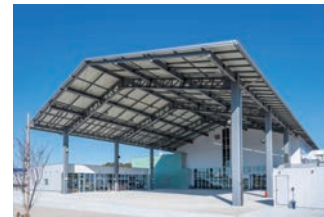
3 道の駅「まえばし赤城」の建設
